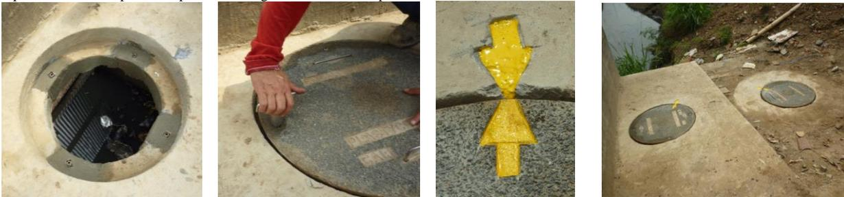
Cámara Especial para protección de Compuerta con tuercas, Instalación y asegurada de TAPA, Guías de Instalación y Tapas Instaladas y Aseguradas.
