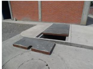
Tapas ahuecadas para cámara de aguas negras ensambladas una con otra.
