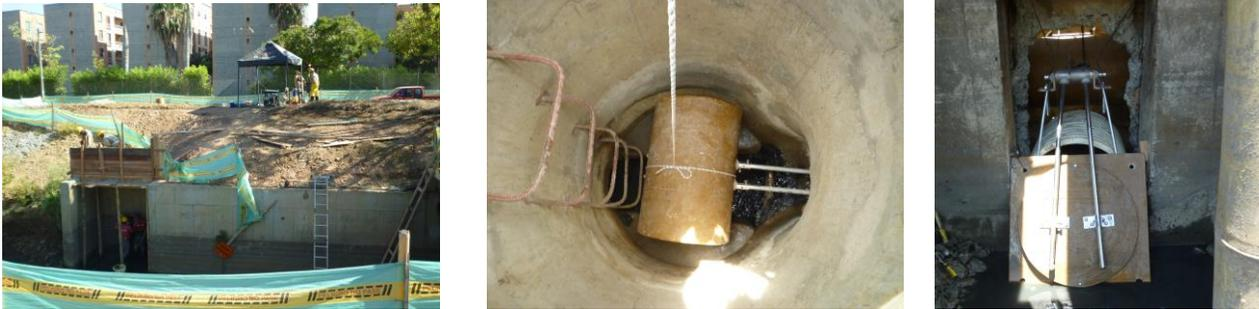
Compuerta Basculante para Recuperación de Aguas Contaminadas para direccionarlas a la PLANTA DE TRATAMIENTO DE AGUAS RESIDUALES
