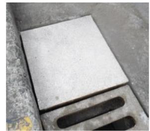
Tapas Baffle o Ciega que van con las Rejillas Sumidero Tipo EMCALI – Vistas superior e inferior de alta y media resistencia.
