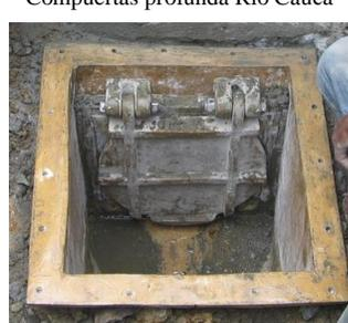
Compuerta con cámara de Instalación
